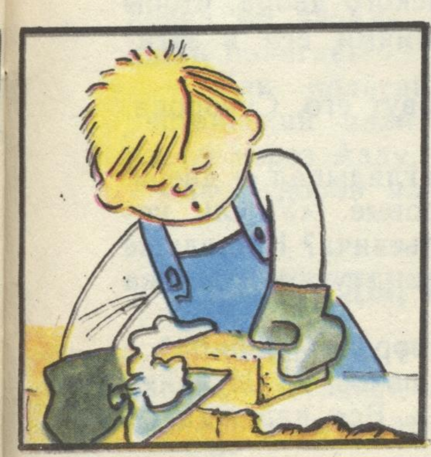
Избыток раствора подрезайте кельмой за один прием.
