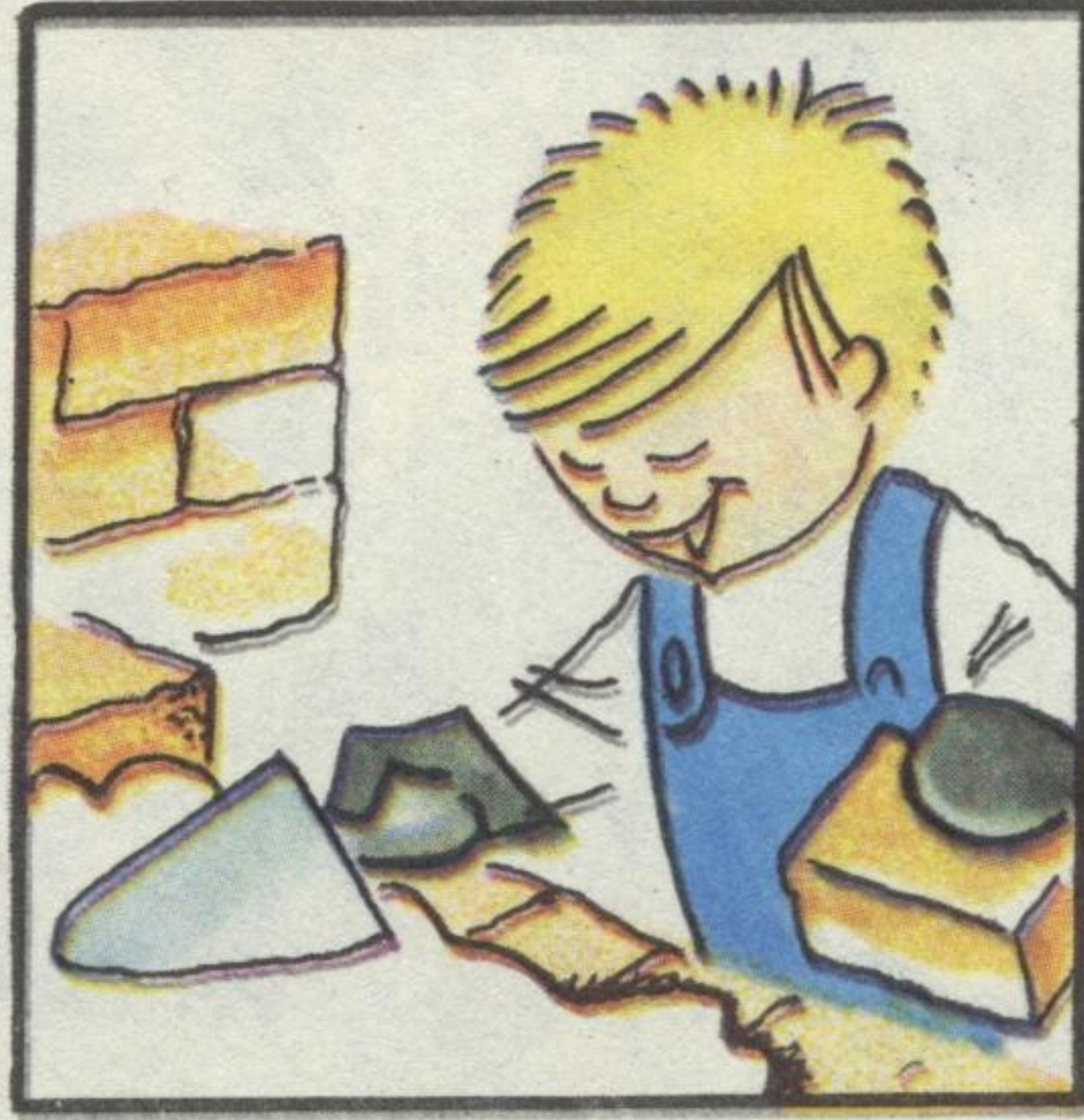
Вынимайте кельму, а кирпичом зажимайте раствор между вертикальными гранями.
